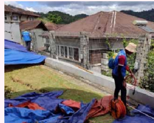
Survei Keberintangan 2D di kawasan tanah runtuh Bukit Antarabangsa, Selangor
