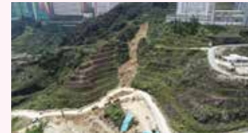
Kejadian tanah runtuh di Jalan Ion D'lemen Genting Highlands
