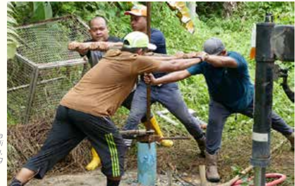
Pencucian telaga tiub di Kg. Orang Asli Sarang, Pos Betau, Kuala Lipis, Pahang
