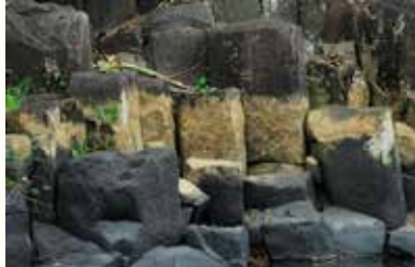
Kekar (Joint) Lokasi: Sg. Balung, Tawau
