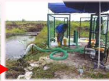
Pengepaman Air Tanah Ke Dalam Saliran
