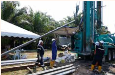
Penggerudian telaga tiub di Pusat Tarbiyah Hafaz Al-Quran Ibnu Sina, Kamunting, Perak
