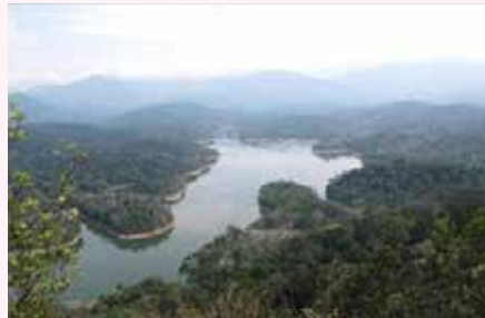
Empangan Klang Gates, Selangor
