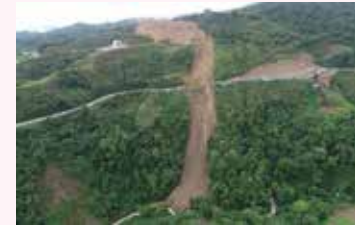
Imej fotudara tanah runtuh di Jalan Kundasang – Ranau, Sabah
