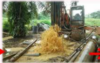
Penggerudian Hingga Ke Akuifer Dan Pembinaan Telaga
