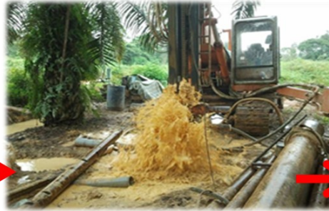
Penggerudian Hingga Ke Akuifer Dan Pembinaan Telaga
