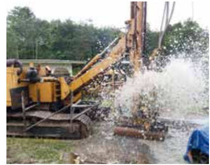
Penggerudian dan pembinaan telaga tiub di Kg. Tangkol, Kota Marudu. Drilling and construction of tube well at Kg. Tangkol, Kota Marudu.
