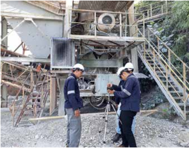
Pemasangan alat untuk penyelidikan korelasi punca bunyi dari alat pemecah (crusher) sedang dilakukan. Installation of instruments for correlation of noise from crushing activity at quarry site
