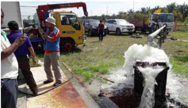
Pemasangan dan pengujian pam selam baru untuk telaga air bawah tanah di Sekolah Menengah Sains Bagan Datuk (SABDA). Installation and testing of new submersible pump for groundwater well at Sekolah Menengah Sains Bagan Datuk (SABDA).
