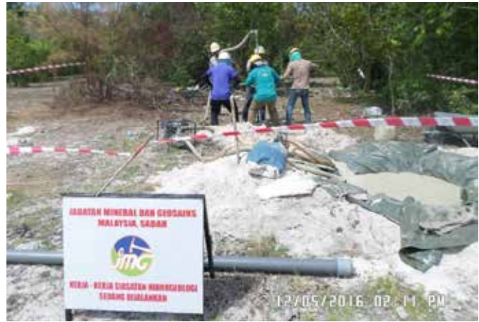
Pengejetan telaga eksplorasi di Pulau Mantanani, Sabah Jetting of exploration well in Pulau Mantanani, Sabah
