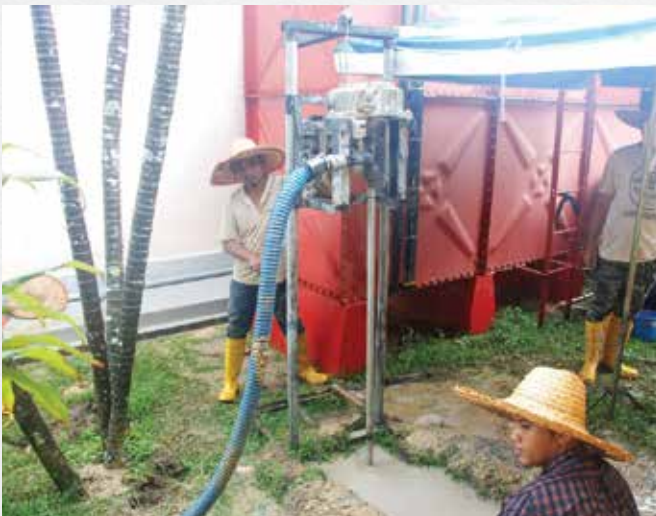
10.01.2015 Kerja-kerja pembinaan telaga tiub menggunakan kaedah pengejetan di Wisma Persekutuan Kota Bharu Construction of tubewells using jetting method at Wisma Persekutuan Kota Bharu
