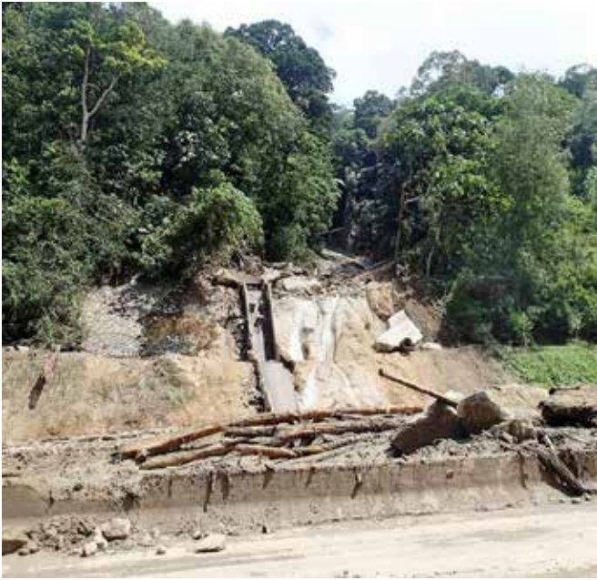
Kejadian aliran puing dan lumpur di KM52.4 Lebuhraya KL-Karak, Bentong, Pahang pada November 2015 yang menutupi keseluruhan lebuhraya berkenaan serta menyebabkan gangguan trafik selama 3 hari
