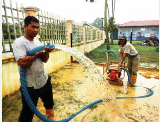
09.01.2015 Pengepaman air dari telaga tiub yang telah siap di UDK Mahligai Pumping of water from the completed tubewell at UDK Mahligai
