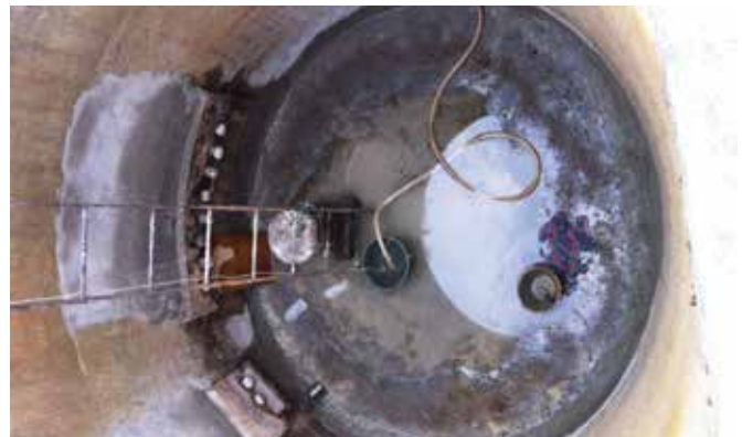
Pengubahsuaian caisson sebagai telaga pengumpul dengan pemasangan GI paip di dindingnya, Raub, Pahang Modification of caisson as an accumulation well by installing GI pipe to the wall, Raub, Pahang
