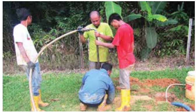
Photo: Mohd. Shahrizal Mohamed Sharifodin Kerja-kerja pembinaan telaga tiub pemantauan air tanah menggunakan kaedah pengejetan di Hulu Perak Construction of monitoring tubewells using jetting method at Hulu Perak
