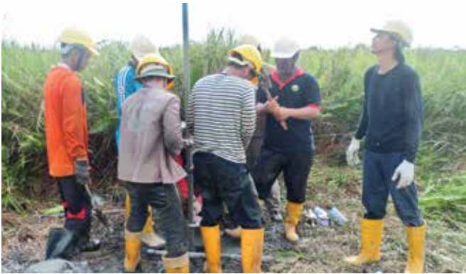
Program Pengurusan Tanah Gambut Yang Sering Terbakar. Penggerudian kaedah pengejetan bagi pembinaan telaga tiub di Kuala Penyu, Sabah Peat Fire Management Program. Construction of monitoring tubewells using jetting method at Kuala Penyu, Sabah
