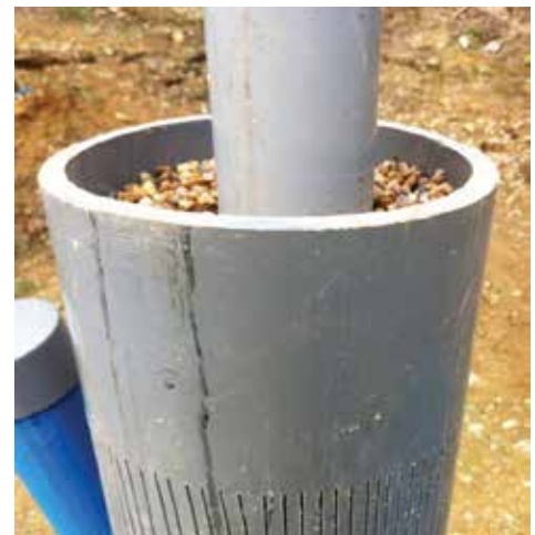
Pengubahsuaian caisson sebagai telaga pengumpul dengan pemasangan GI paip di dindingnya, Raub, Pahang Modification of caisson as an accumulation well by installing GI pipe to the wall, Raub, Pahang
