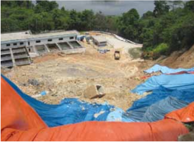
Tanah runtuh pada cerun potongan di Loji Rawatan Air Gerik V, Bersia, Gerik, Perak. Landslide on cut slope at Gerik V Water Treatment Plant, Bersia, Gerik, Perak.
